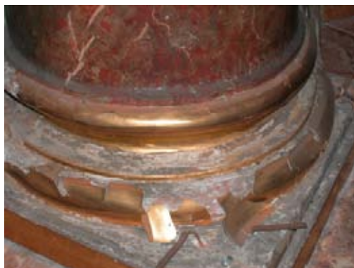
nach der Restaurierung (rechts)
