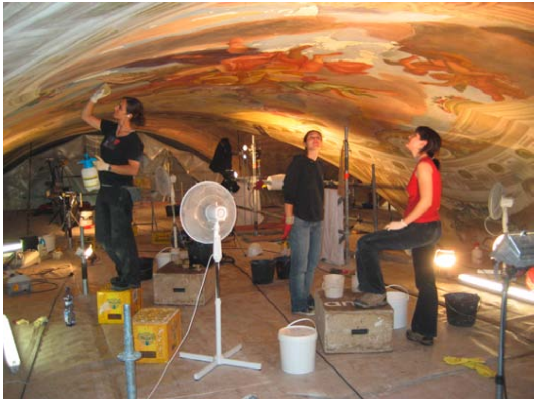
Das Restauratorenteam bei der Behandlung der Gewölbemalereien
