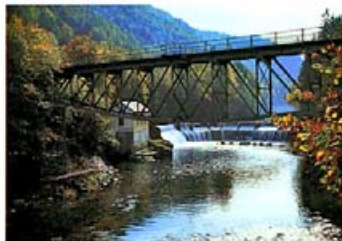
Eisenbahnbrücke bei Gitsdorf über die Ybbs
