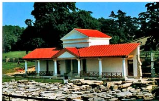
Im antiken Stadtviertel bei Schloß Petronell wurde 1990–1991 im Einvernehmen mit der Denkmalbehörde erstmals in Österreich die Vollrekonstruktion eines antiken Gebäudes errichtet. Die Aufnahme zeigt einen Dianentempel mit Halle an der restaurierten Limenstraße.
