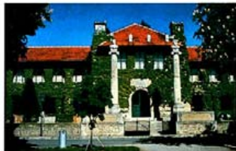
Archäologie Museum Carnuntum vor der Restaurierung. Im Laufe der Jahrzehnte seit seiner Errichtung durch Fried- rich Ohmann hat dieses in Österreich einmalige Museumgebäude zahl- reiche Verunklärungen und Fehlinterpretationen erfahren.
