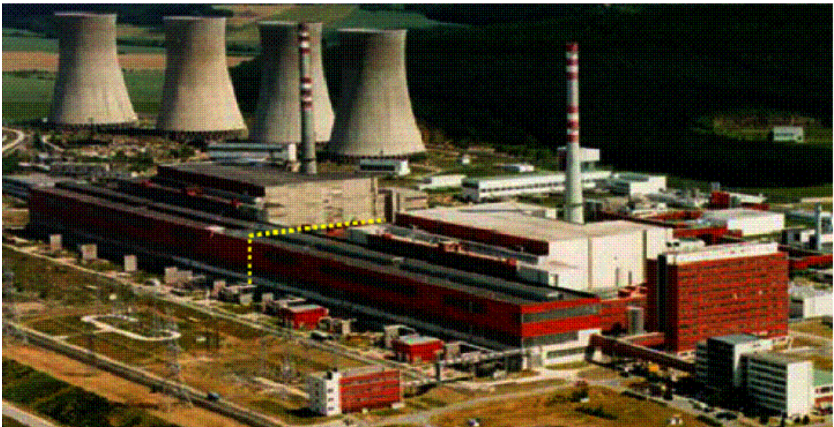
Abbildung 10: Luftaufnahme mit der rotwandigen Turbinenhalle zwischen den Zwillingsblöcken von Mochovce 1-4. Die gelb gepunktete Linie bezeichnet die Grenzlinie zwischen den Blöcken 1&2 und 3&4. 14
