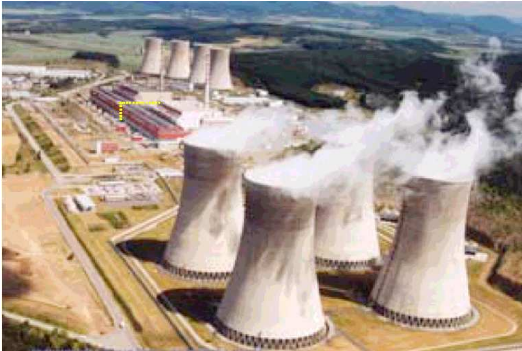
Abbildung 1: Luftaufnahme des KKW Mochovce, in einer für WWER440-213 7 typischen Anordnung.
