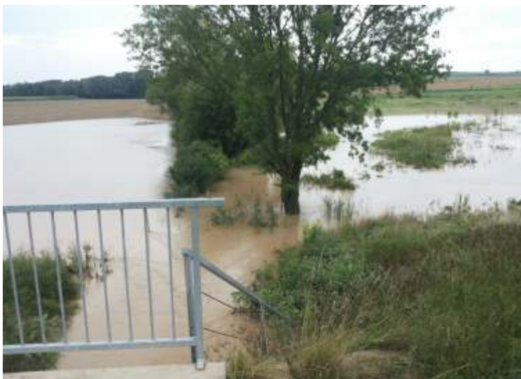
Rückhaltebecken Porraubach bei Viendorf
