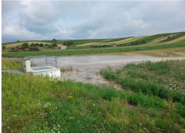
Rückhaltebecken Lussbergweg in Auersthal
