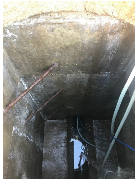
Abbildung 13+ 14: Schachtbauwerk nach Abschluss der Flutungen (gut erkennbar die weißen Verhärtungsspuren im Bereich der vorhandenen Risse im Bauwerk)
