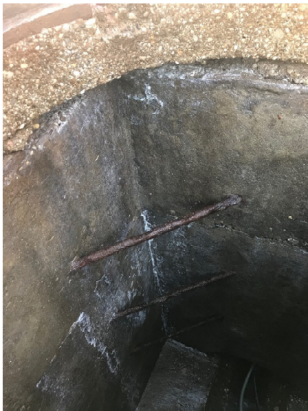
Abbildung 13+ 14: Schachtbauwerk nach Abschluss der Flutungen (gut erkennbar die weißen Verhärtungsspuren im Bereich der vorhandenen Risse im Bauwerk)
