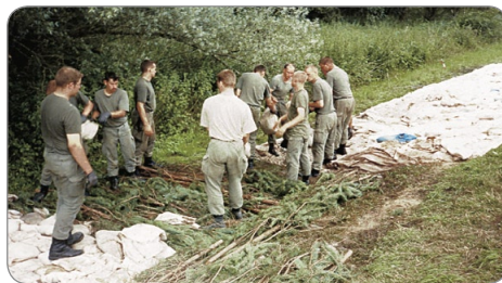
Dammfußsicherung mit Faschinen und Sandsäcken
