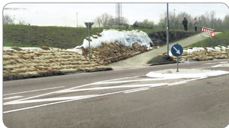
Verlegung der Sandsäcke auf speziellem Geotextil
