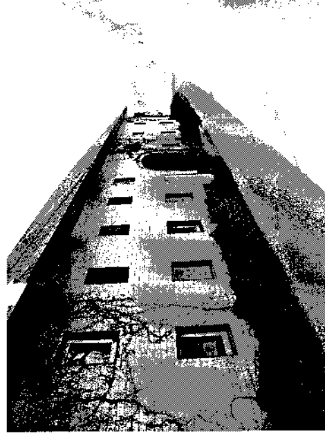
Ansichten des Gebäudes; oben: Wohnhausteil, unten: Westtrakt
